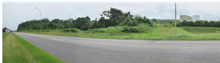
Figure 9: Vue de l'accès au site - Source : Composite
